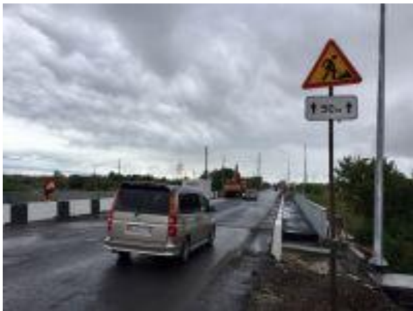
Рис.1 ( мост через р. Березовка)
